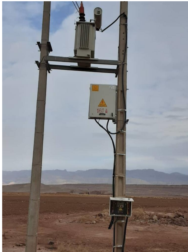
شکل ۱۴: نصب تابلو لوازم اندازه گیری زیر سکو ترانسفورماتورهای دوپایه (دروازه‌ای)
