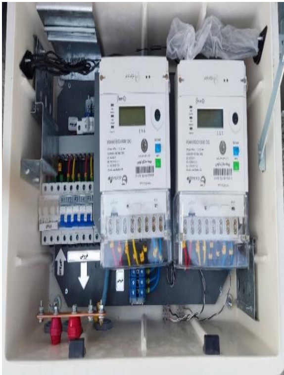
شکل ۹: نصب تابلو سایز کوچک دو کنتور سه فاز هوایی
