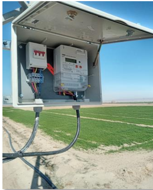
شکل ۷: نمونه تابلو سه فاز هوایی به همراه تابلو مشترک مورد تایید برای نصب کلید مینیاتوری سه فاز روی پایه یا در داخل ملک مشترک
