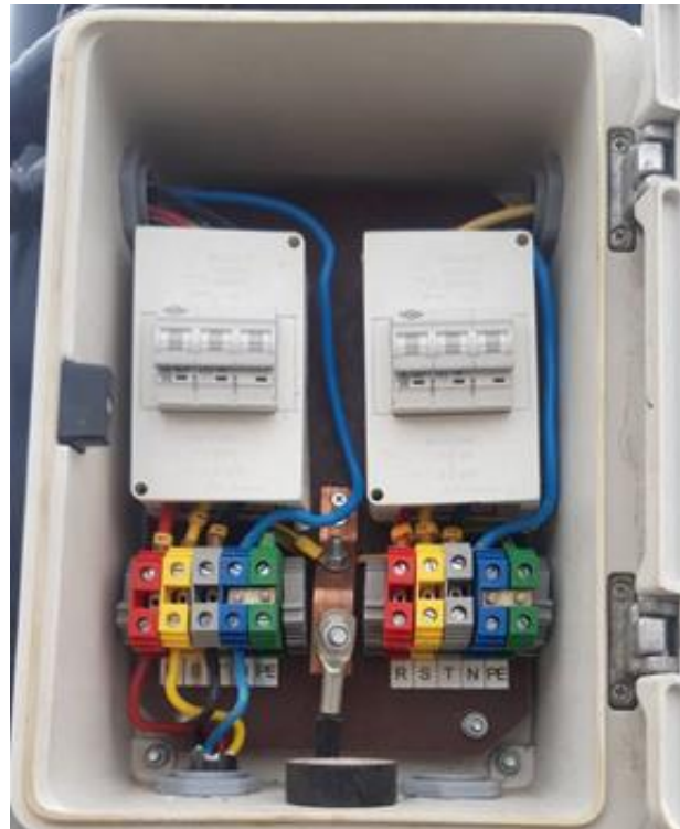
شکل ۱۰: نمونه تابلو دو مشترک سه فاز
