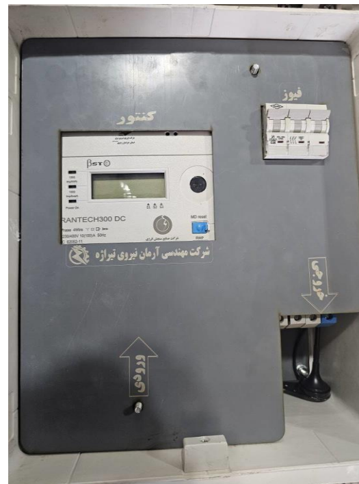
شکل ۸: تابلو سه فاز دیواری با روبند قابل نصب در ملک مشترک
