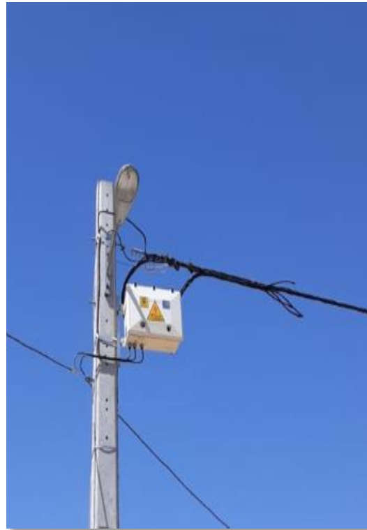
شکل ۹: نصب تابلو سایز کوچک دو کنتور سه فاز هوایی
