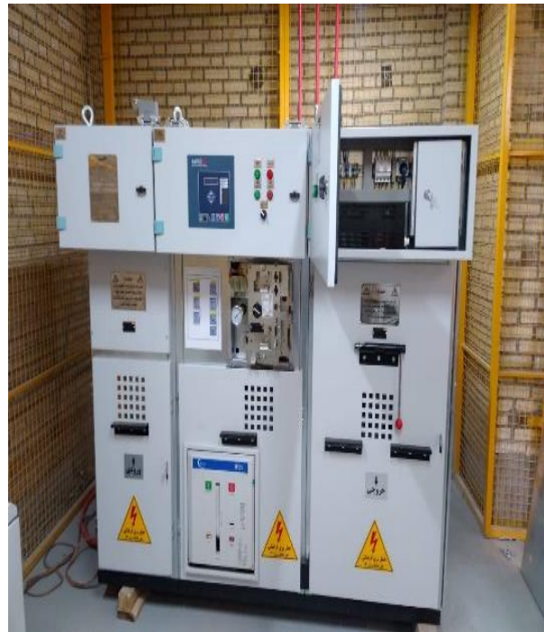
شکل ۱۶: نمونه نصب کنتور در تابلو اندازه گیری ولتاژ اولیه
