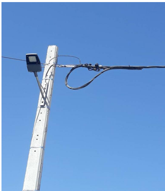
شکل ۶: نصب صحیح کانکتور انشعابی
