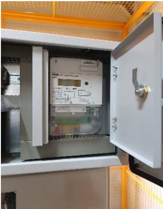
شکل ۱۶: نمونه نصب کنتور در تابلو اندازه گیری ولتاژ اولیه
