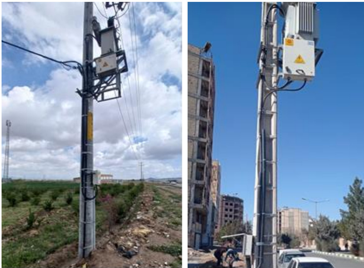
شکل ۱۳: نصب تابلو روی سکوی ترانسفورماتور
