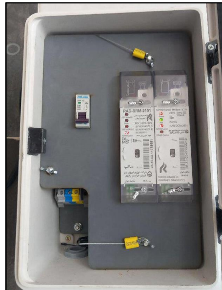
شکل ۳: نصب کنتور ریلی فهام ۲ به همراه مودم (تا دو کنتور) در داخل ملک مشترک
