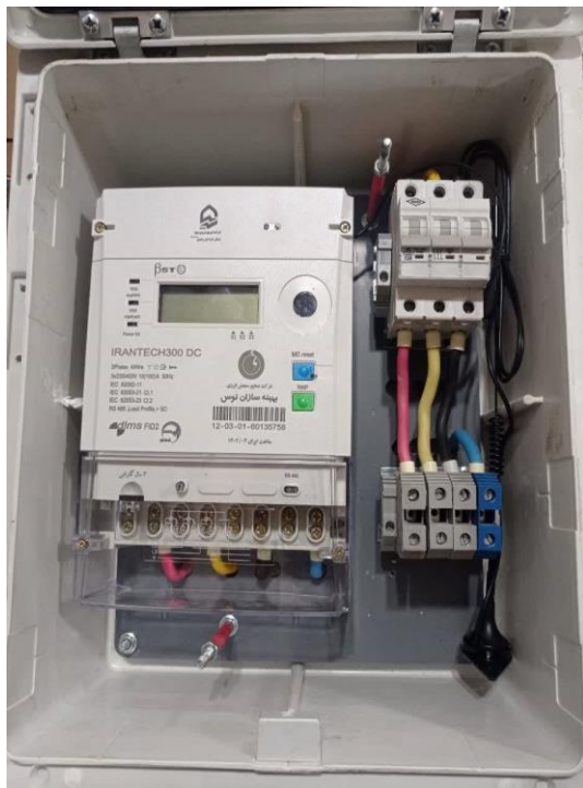
شکل ۸: تابلو سه فاز دیواری با روبند قابل نصب در ملک مشترک
