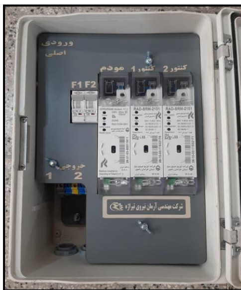
شکل ۳: نصب کنتور ریلی فهام ۲ به همراه مودم (تا دو کنتور) در داخل ملک مشترک
