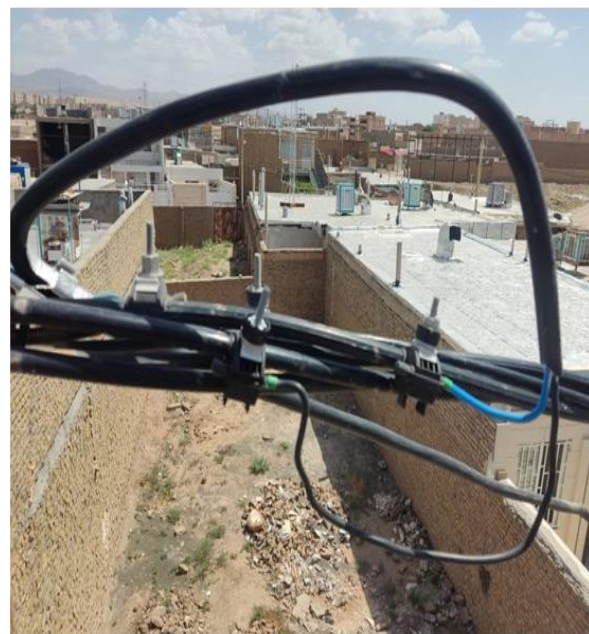
شکل ۶: نصب صحیح کانکتور انشعابی
