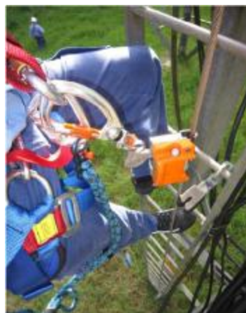
شکل 34- استفاده از طناب نجات یا سیم بکسل
