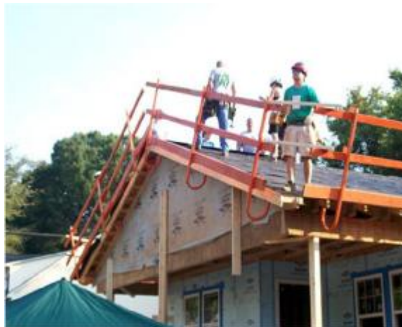
شکل 9- حفاظ گذاری لبه سقف شیب دار
